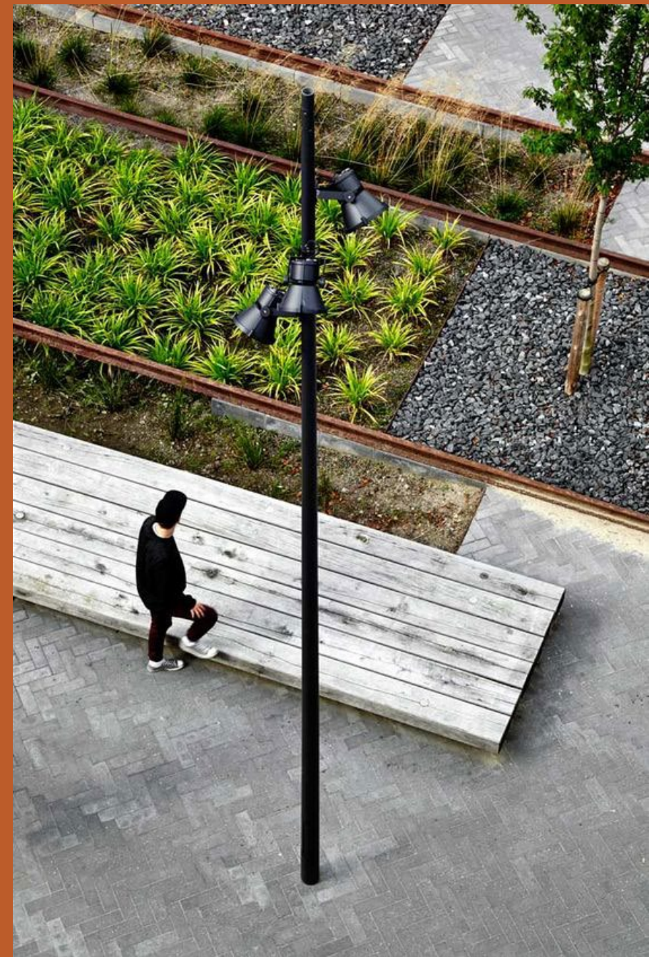
Esimerkki rautatieteen tuomisesta katuaukiolle. Istutusalueet on rajattu vanhoja ratakiskoja hyödyntäen. Kohde: Godsbanearailet, Aalborg, Tanska. (© Wichmann+Bendtsen)
